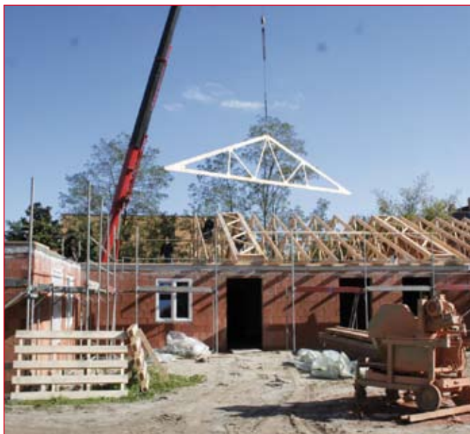
Der Neubau in der Nikolaus-von-Halem-Straße in Nord: Einzugs ist im Mai 2011 geplant.
