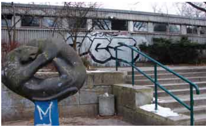
Turnhalle der Sprengel-Schule ist ein alarmierendes Beispiel für den Zustand an Brandenburger Bildungseinrichtungen
